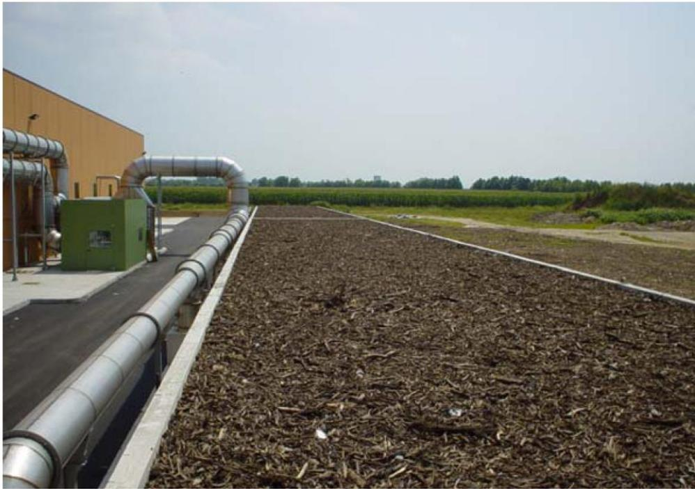
Figura 137: Esempio di biofiltro
