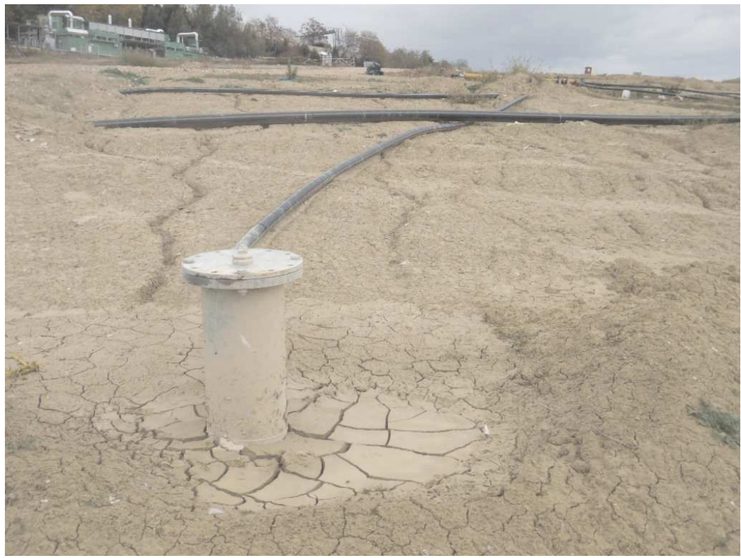
Foto 9: pozzo di captazione di biogas esistente
