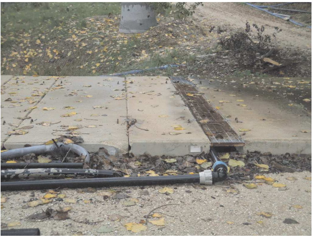
Foto 4: vasca in c.a esistente di accumulo percolato
