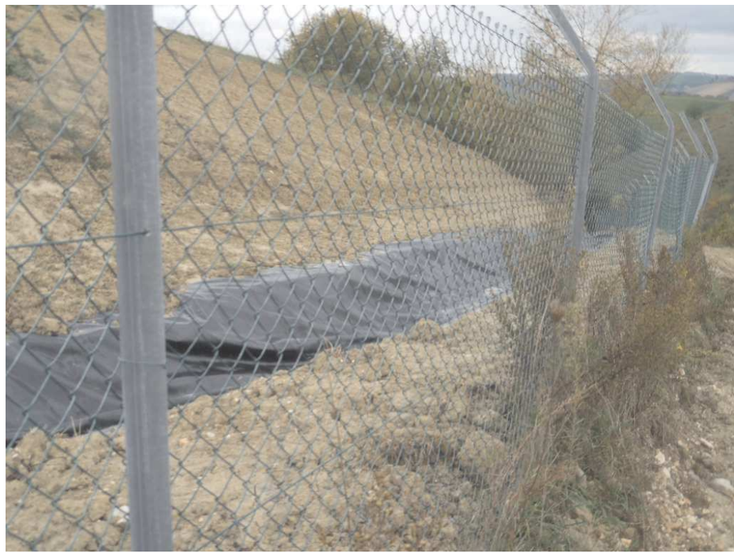
Foto 5: canaletta superficiale di raccolta delle acque esistente con telo HDPE
