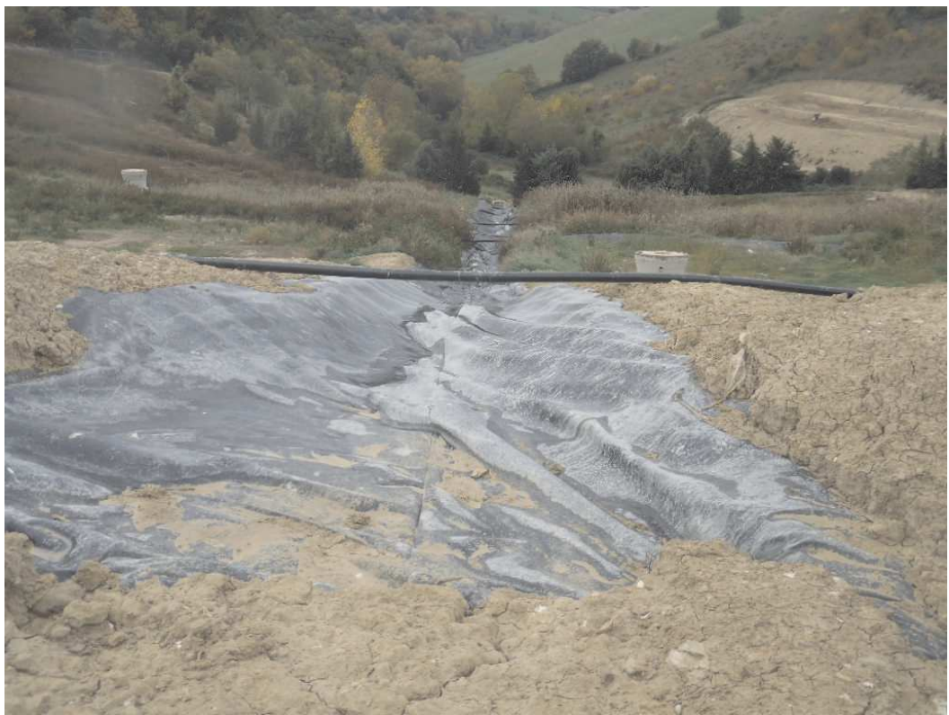
Foto 6: canaletta superficiale principale di raccolta delle acque esistente con telo HDPE
