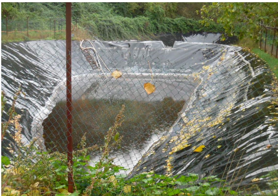
Figura 2: Foto 2-Sistema di stoccaggio percolato con due laghetti
