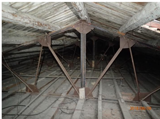
Figura 7. Capriata reticolare in acciaio
