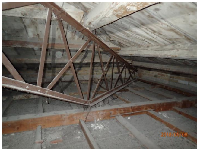
Figura 3. Trave reticolare in acciaio
