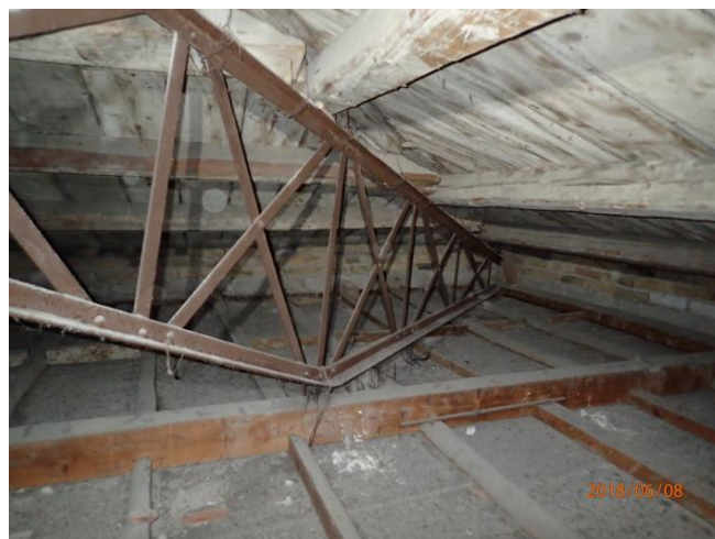
Figura 8. Trave reticolare in acciaio
