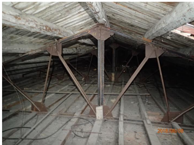
Figura 2. Capriata reticolare in acciaio
