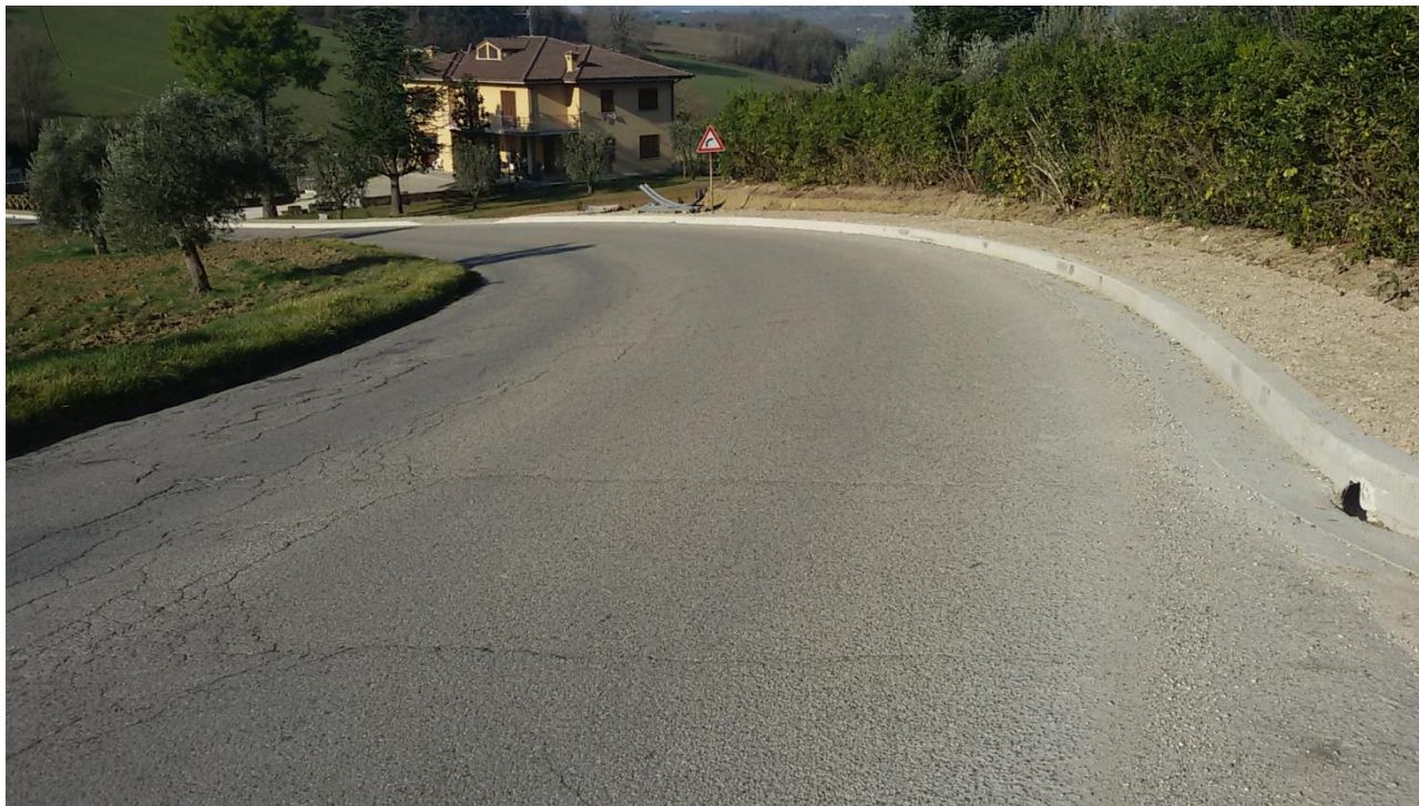
Foto1 - Km 15+500. Fessurazioni longitudinali e trasversali della pavimentazione stradale ed usura dello strato superficiale.
