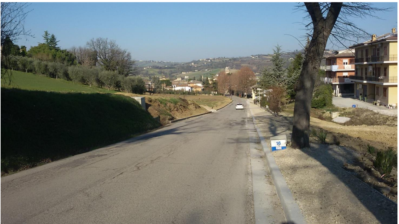
Foto4 - Km 16+000. Avvallamenti del piano viario con fessurazioni longitudinali e trasversali della pavimentazione stradale ed usura dello strato superficiale.
