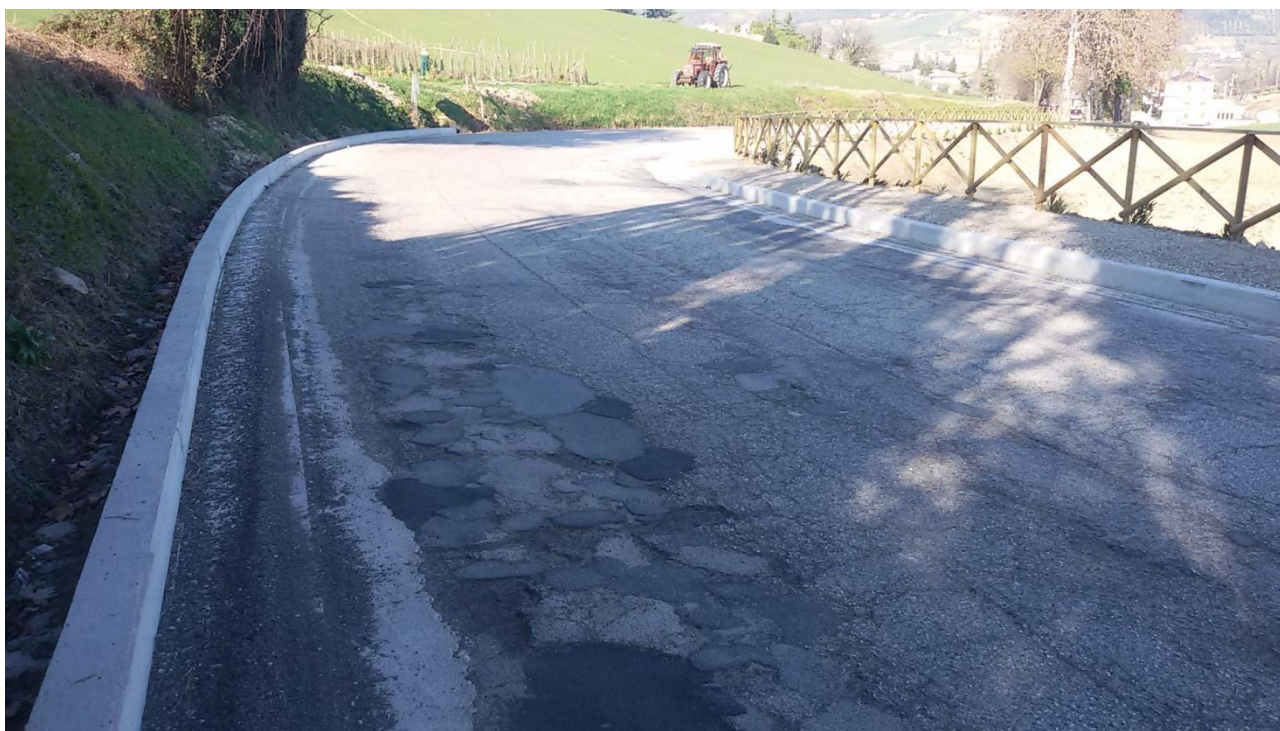
Foto2 - Km 15+700. Avvallamenti del piano viario con fessurazioni longitudinali e trasversali della pavimentazione stradale ed usura dello strato superficiale.
