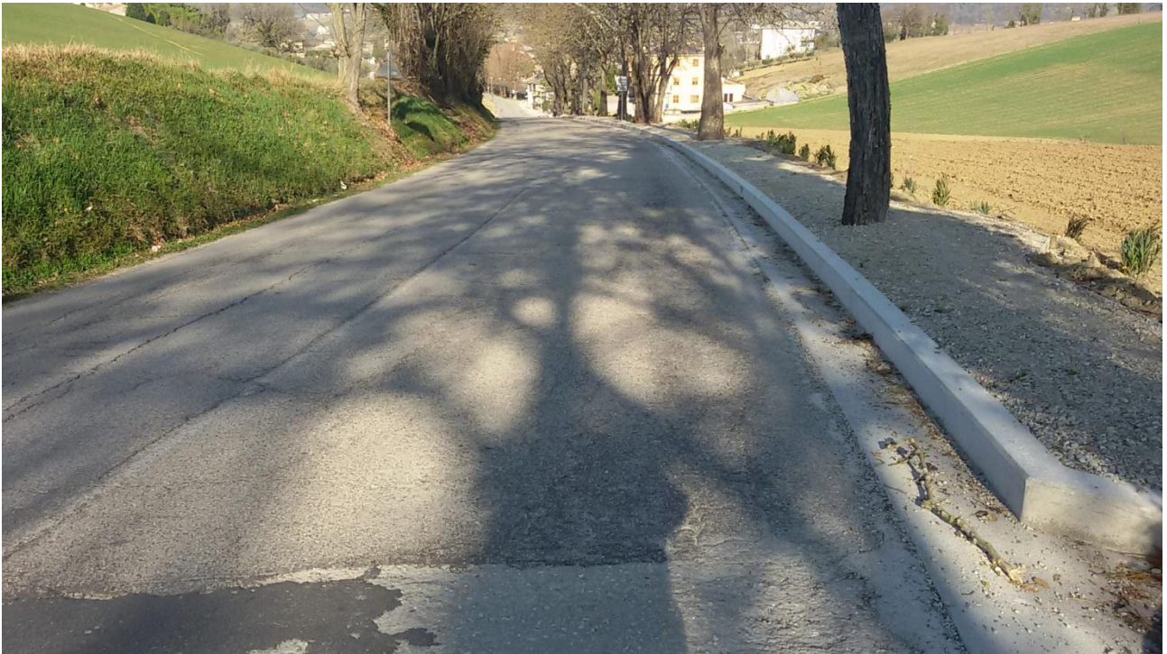
Foto3 - Km 15+800. Avvallamenti del piano viario con fessurazioni longitudinali e trasversali della pavimentazione stradale ed usura dello strato superficiale.
